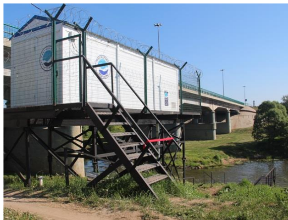
Общий вид станции. Фото с сайта Росгидромета.
